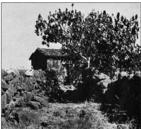
22. Casa de adobe de un trabajador rural dueño de una pequeña parcela que vive principalmente de elaborar sogas y trabajar como jornalero para otros. Ver fotos 33D y 33G.
