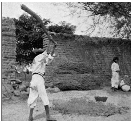
2. Moliendo la arcilla con un golpeador
